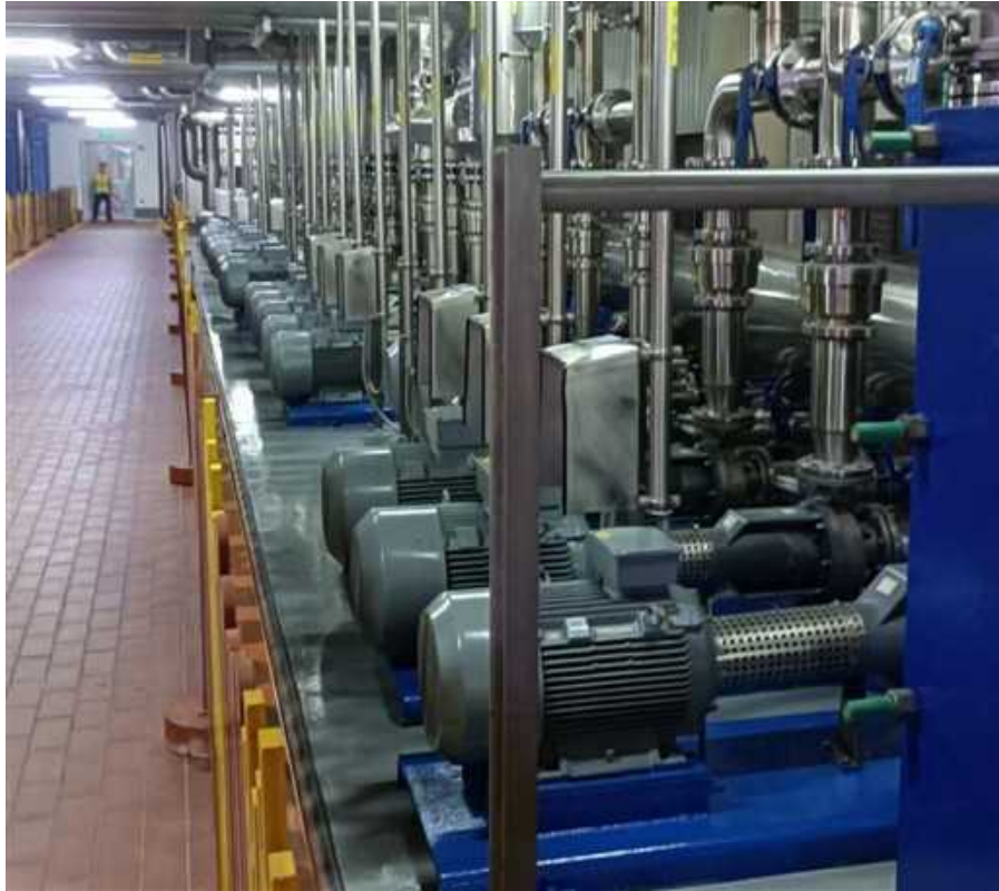
图 2：酿造部泵现场分布图
