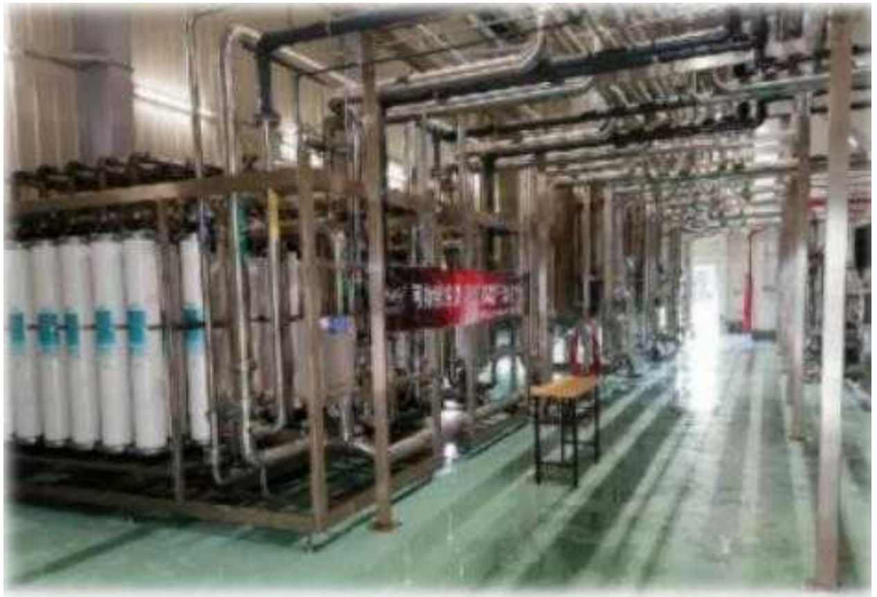
图 6：RO 深度处理回用中水
